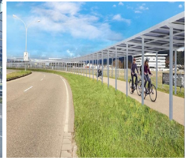
PV Überdachung Radschnellwege Freiburg
