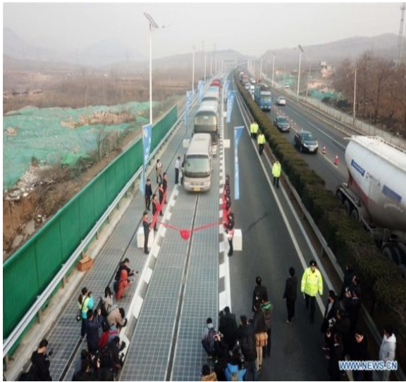
Autobahn PV Straßenbelag China
