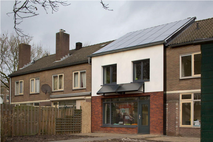
Abbildung 5: Seriell saniertes Reihenhaus
